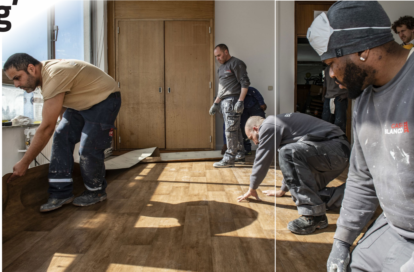
In dit project van de Brusselse arbeidsbemiddelingsdienst Actiris werden jongeren zonder diploma in 2019 opgeleid op een bouwterf.
