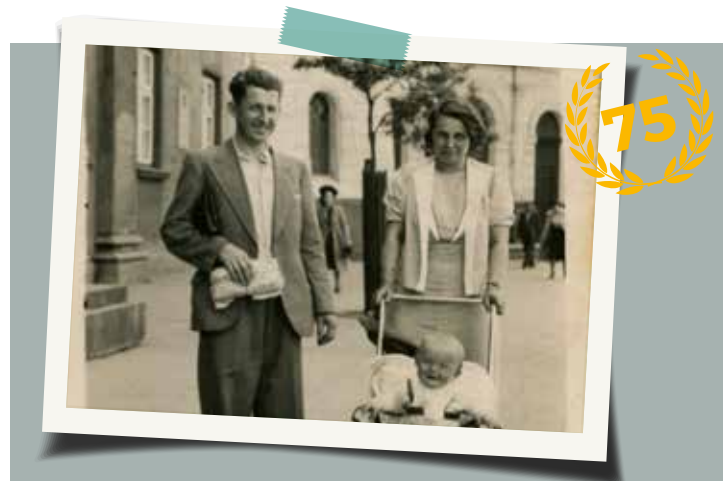
In 1930 komt er een wet op de kinderbijslag. Maar een werkloosheids- en ziekteverzekering zijn nog steeds niet verplicht.
